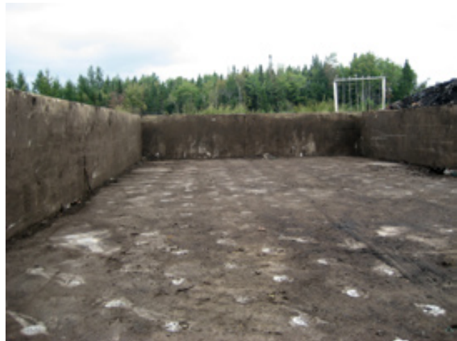
Figure 7-10 (b) Plateforme baie statique aérée
