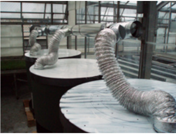
Figures 9-3a (a) et (b) Système de ventilation dans une installation intérieure de vermicompostage
