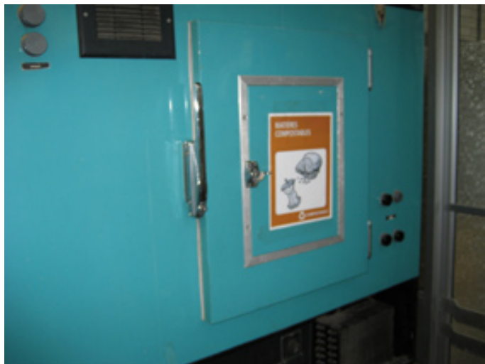
Figure 11-2 Pièce réfrigérée pour entreposer des matières organiques pour plus d'une journée
