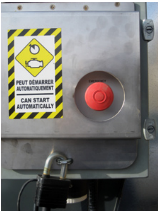
Figure 10-10 Boutons d'arrêt d'urgence sur un équipement mécanique. (a) Ce bouton doit être bien visible et facilement accessible même si un panneau de contrôle doit rester barré. (b) Par mesure de sécurité supplémentaire, certains boutons nécessitent une clé pour être désengagés après un arrêt d'urgence
