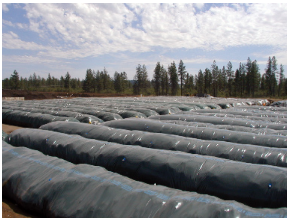
Figure 7-11 Systèmes fermés modulaires statiques utilisant des sacs ou tubes de polyéthylène résistants pour contenir les résidus organiques
