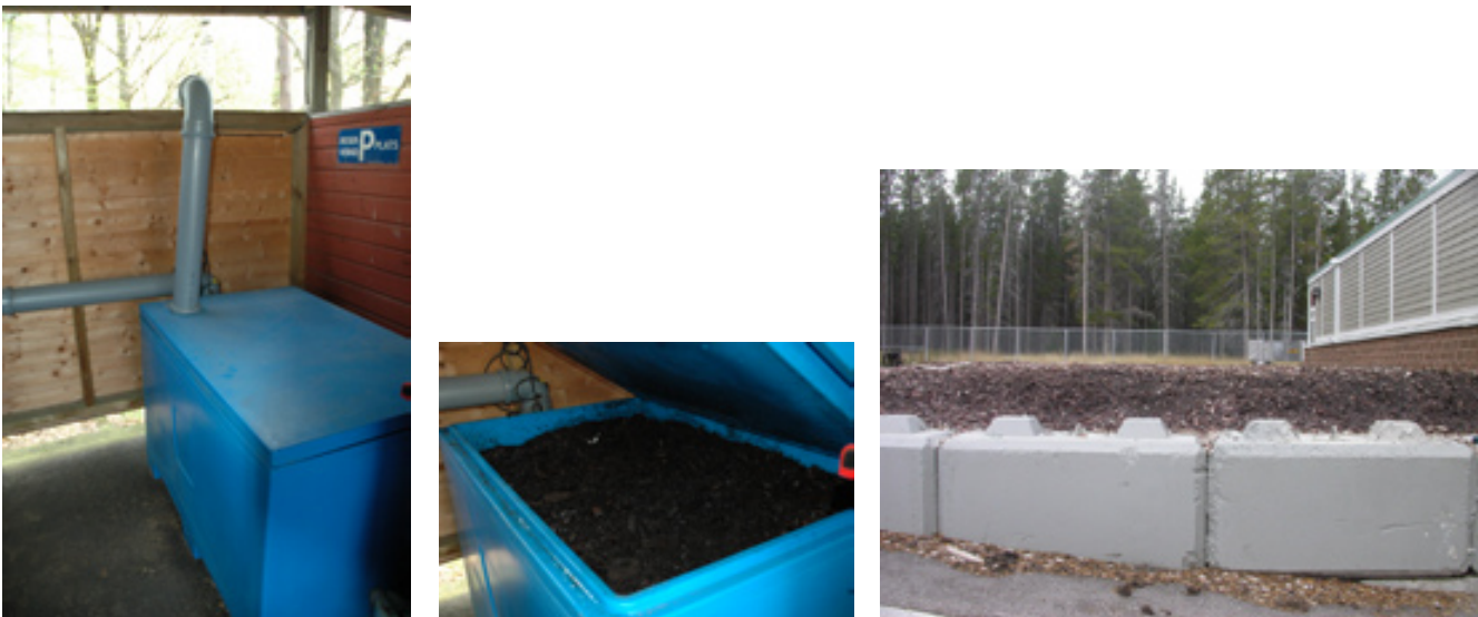
Figure 11-24 Biofiltre utilisé dans (a-b) un système d'échelle intermédiaire et (c) un système à grande échelle
